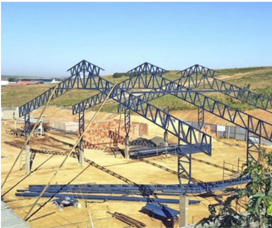
Obras de nova escola em Porto Feliz, no interior de São Paulo, seguem em ritmo acelerado na cidade
