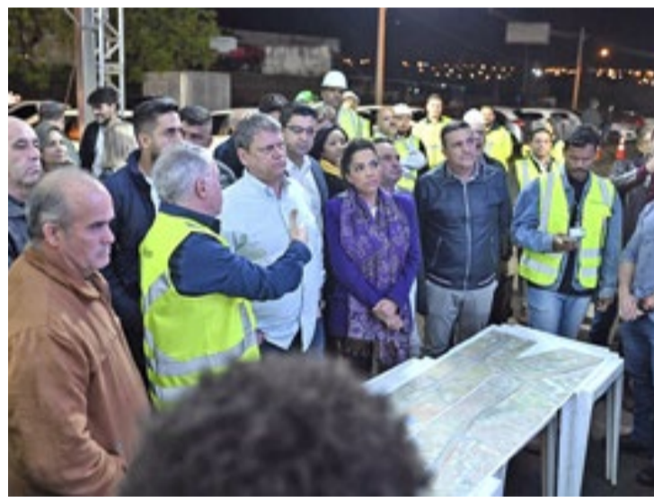
Tarcísio acompanhou a operação de lançamento das vigas dos viadutos que fazem parte da implantação das marginais da rodovia
