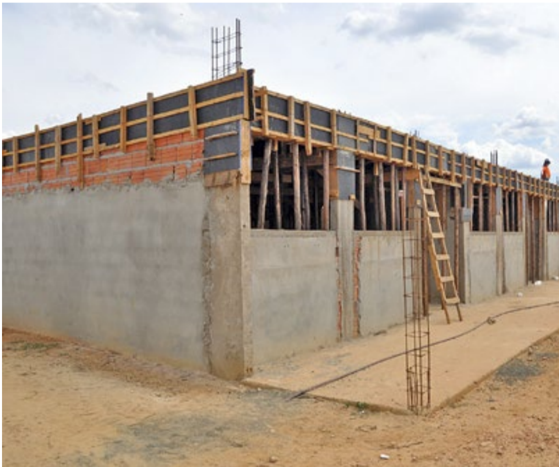
Obras da nova escola em tempo integral do bairro Altos do Jequitibá, em Porto Feliz, no Interior
